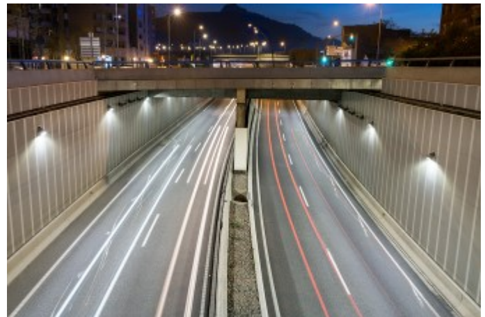
Túnel C-17 Montcada y Reixac, Barcelona - España
